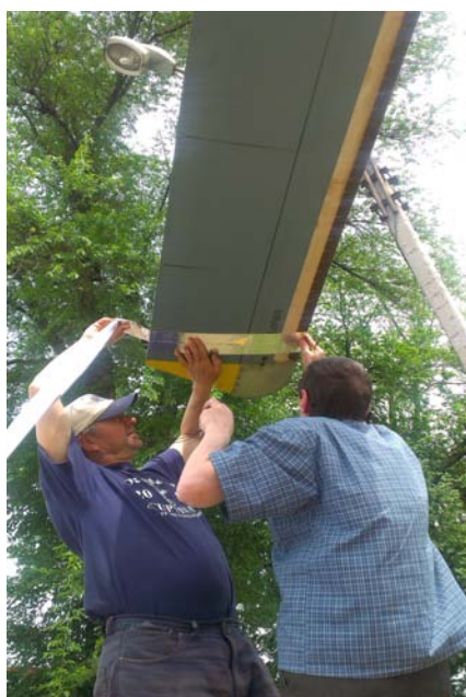
Рис. 2. Установка светоотражающей ленты на лопасть НВ
